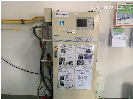
ภาพที่ 2-13 การติดตั้งเครื่องตรวจวัด TOC/COD Online และ pH Meter Online
