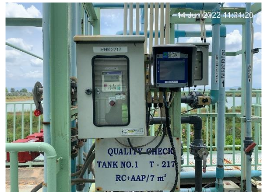
ภาพที่ 2-13 การติดตั้งเครื่องตรวจวัด TOC/COD Online และ pH Meter Online
