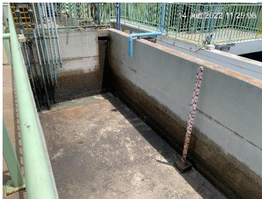
ภาพที่ 2-11 ถังพักน้ำฉุกเฉิน (Emergency Tank)
